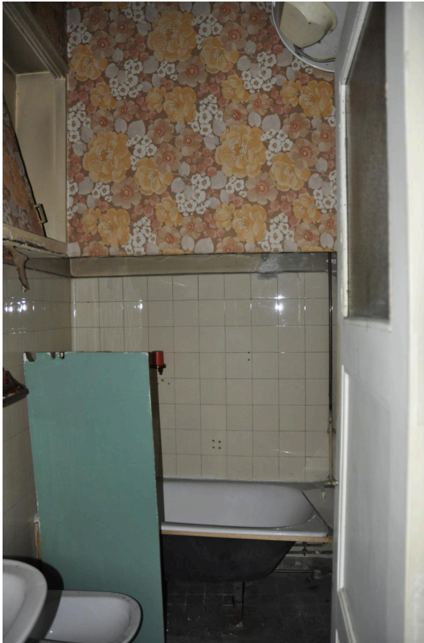
Appartement du 1er étage : salle de bains
