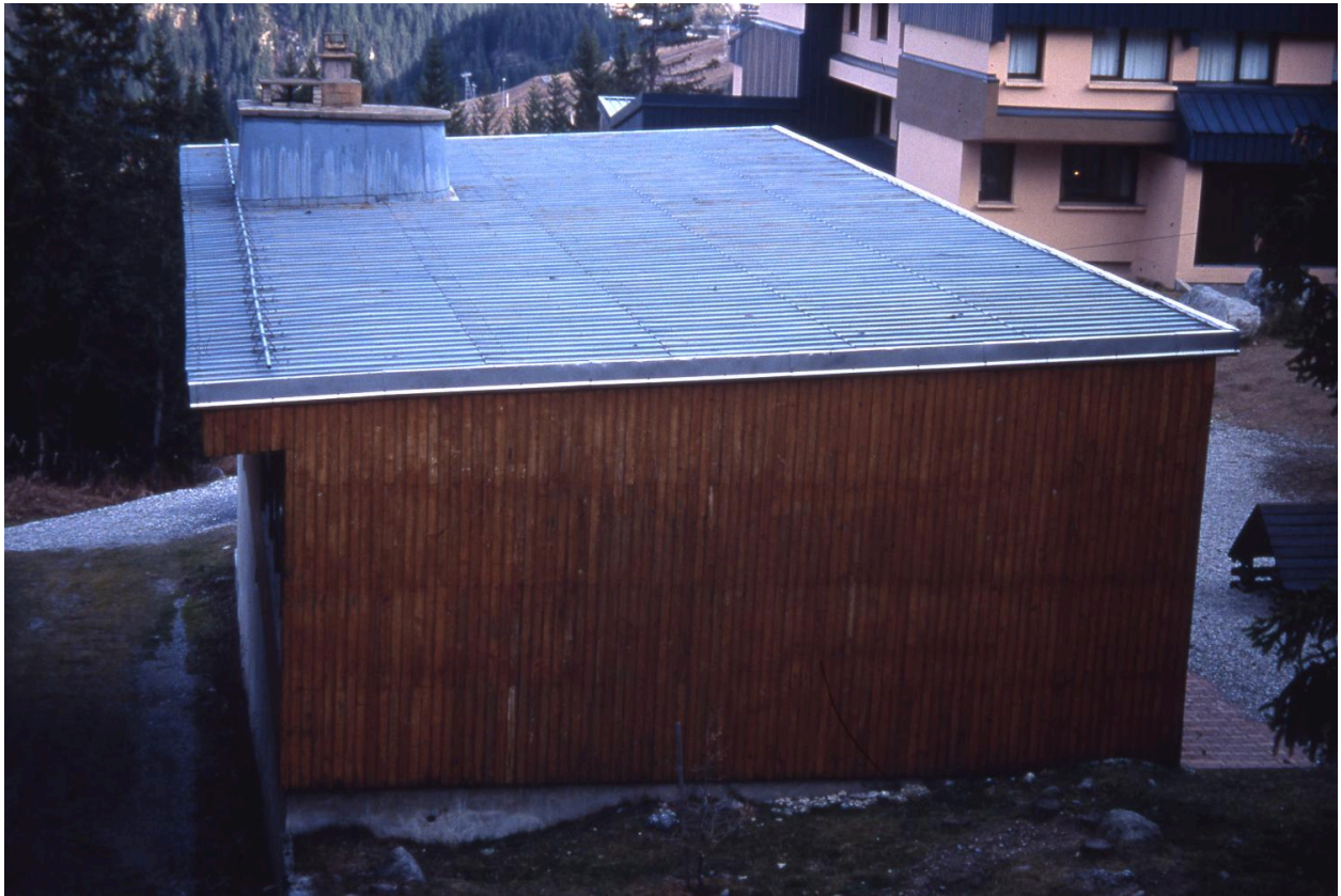
Vue de la toiture
