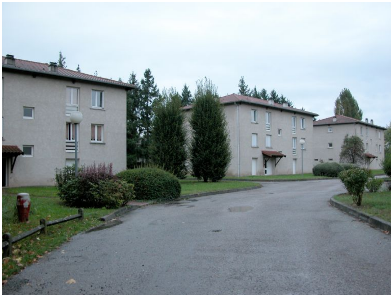
Vue d'ensemble en enfilade des bâtiments n° 10, 11, 12.
