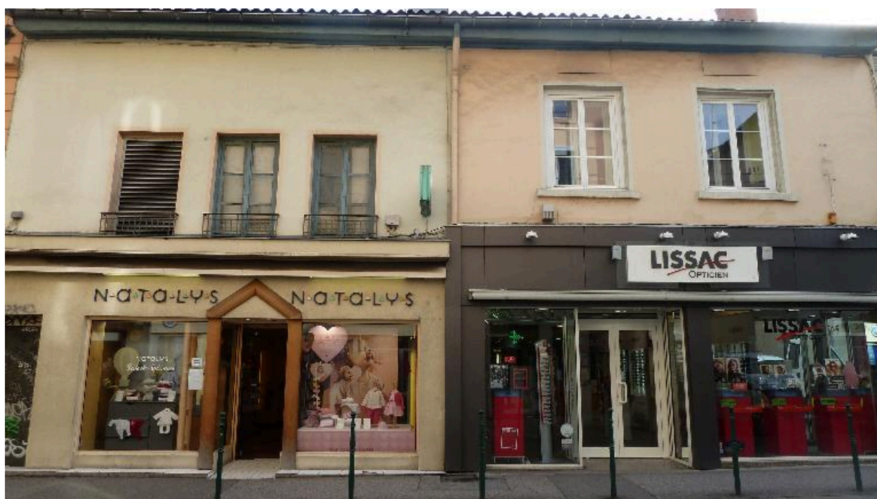
Vue d'ensemble ouest des n° 22 et 20
