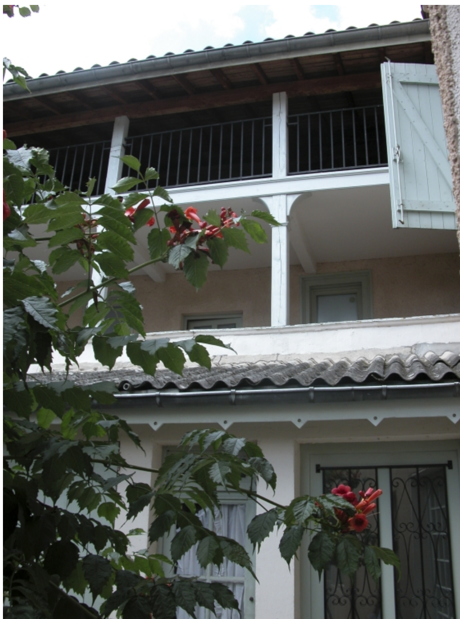
Îlot 9. Carnot (place) 24, 26. Vue partielle de la façade arrière sur la cour.
