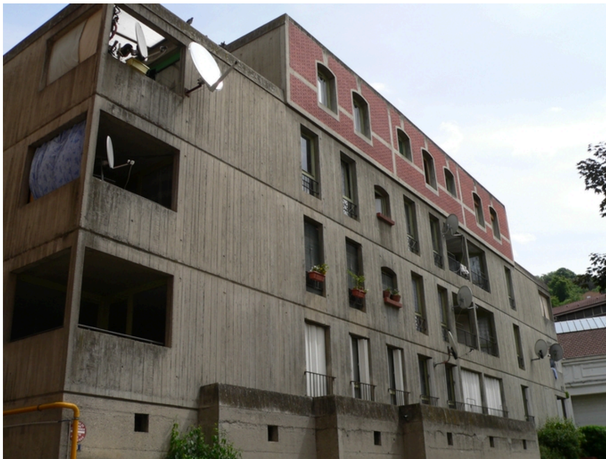
Bâtiment est, façade sud
