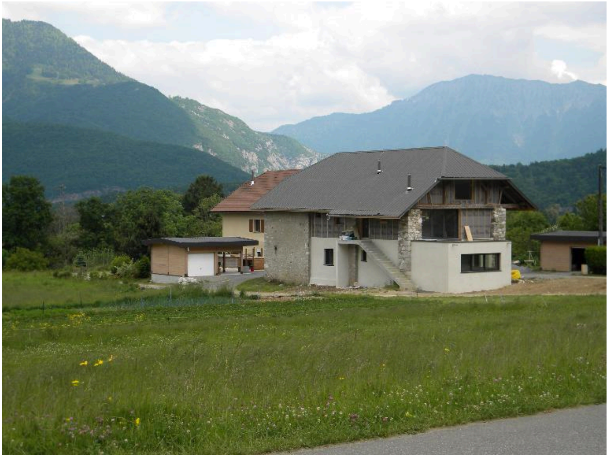
Vue de l'ancienne grange transformée.
