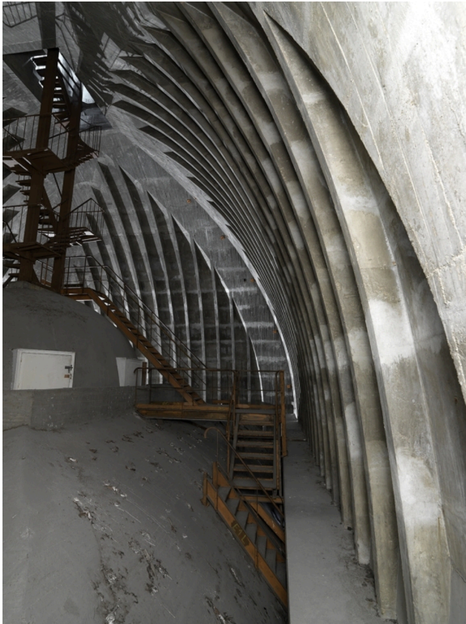
Le dôme Soufflot. La charpente en béton. Détail
