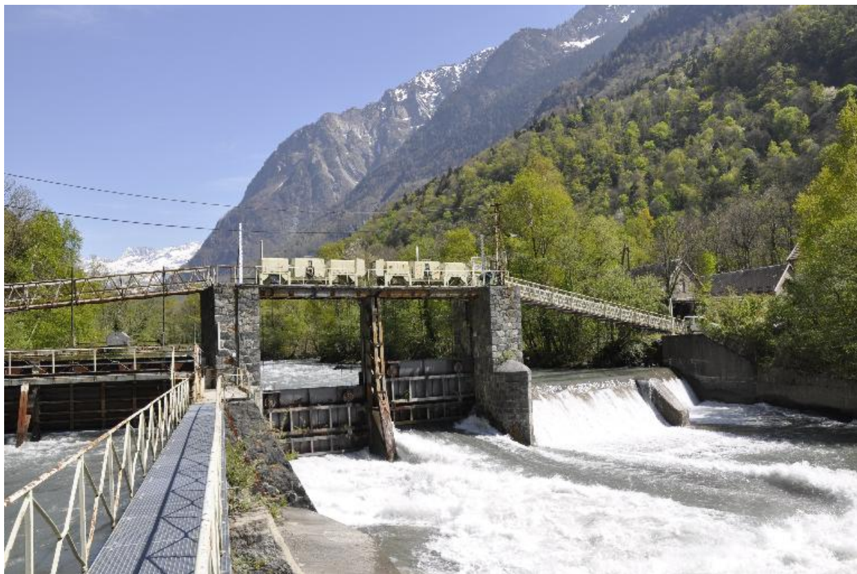
Vue du barrage
