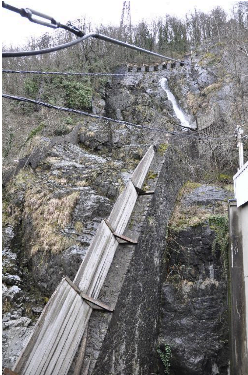
Vue de la chambre de mise en charge de Livet
