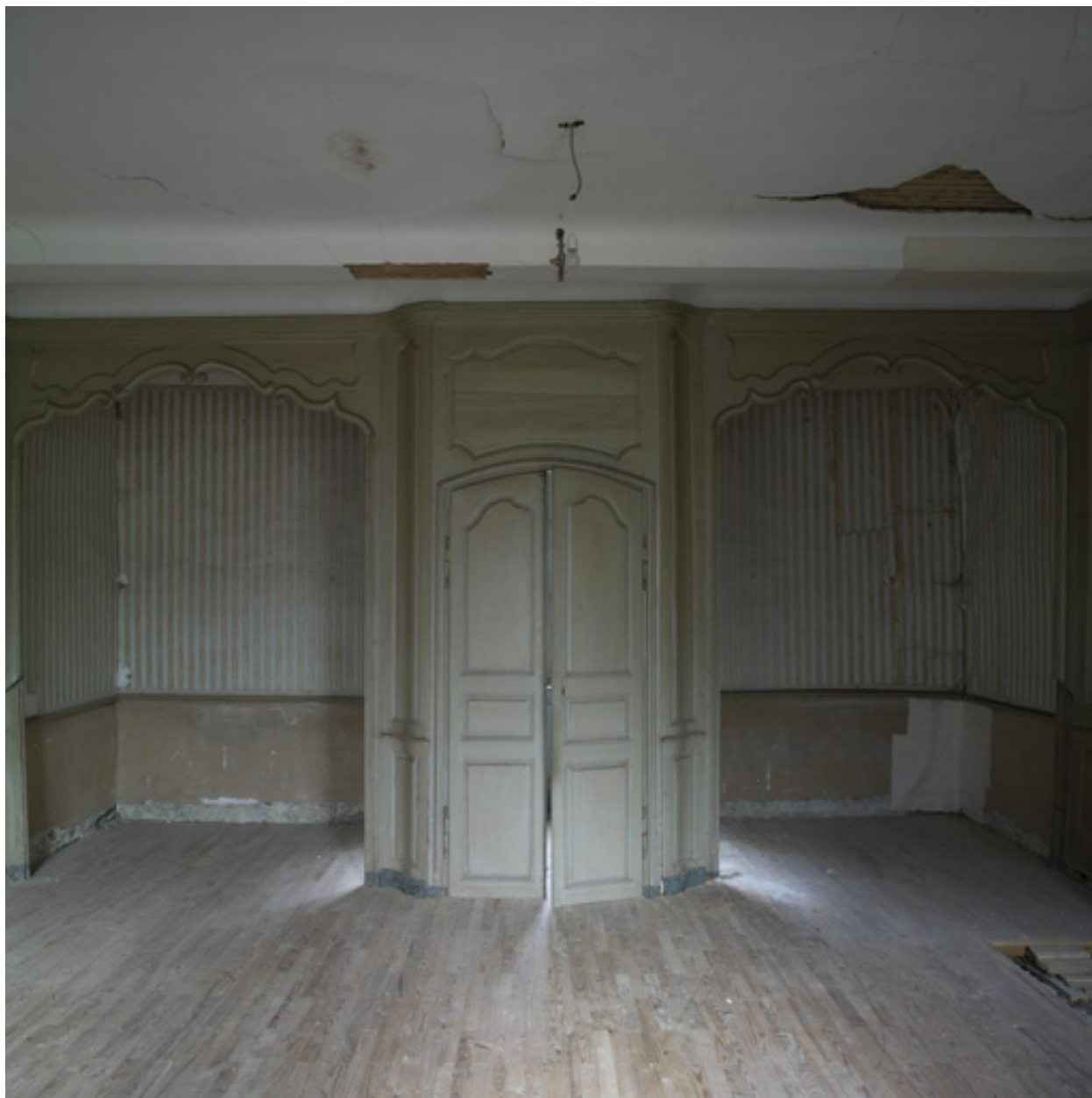
Vue intérieure de la chambre à alcôve du 1er étage du pavillon sud.
