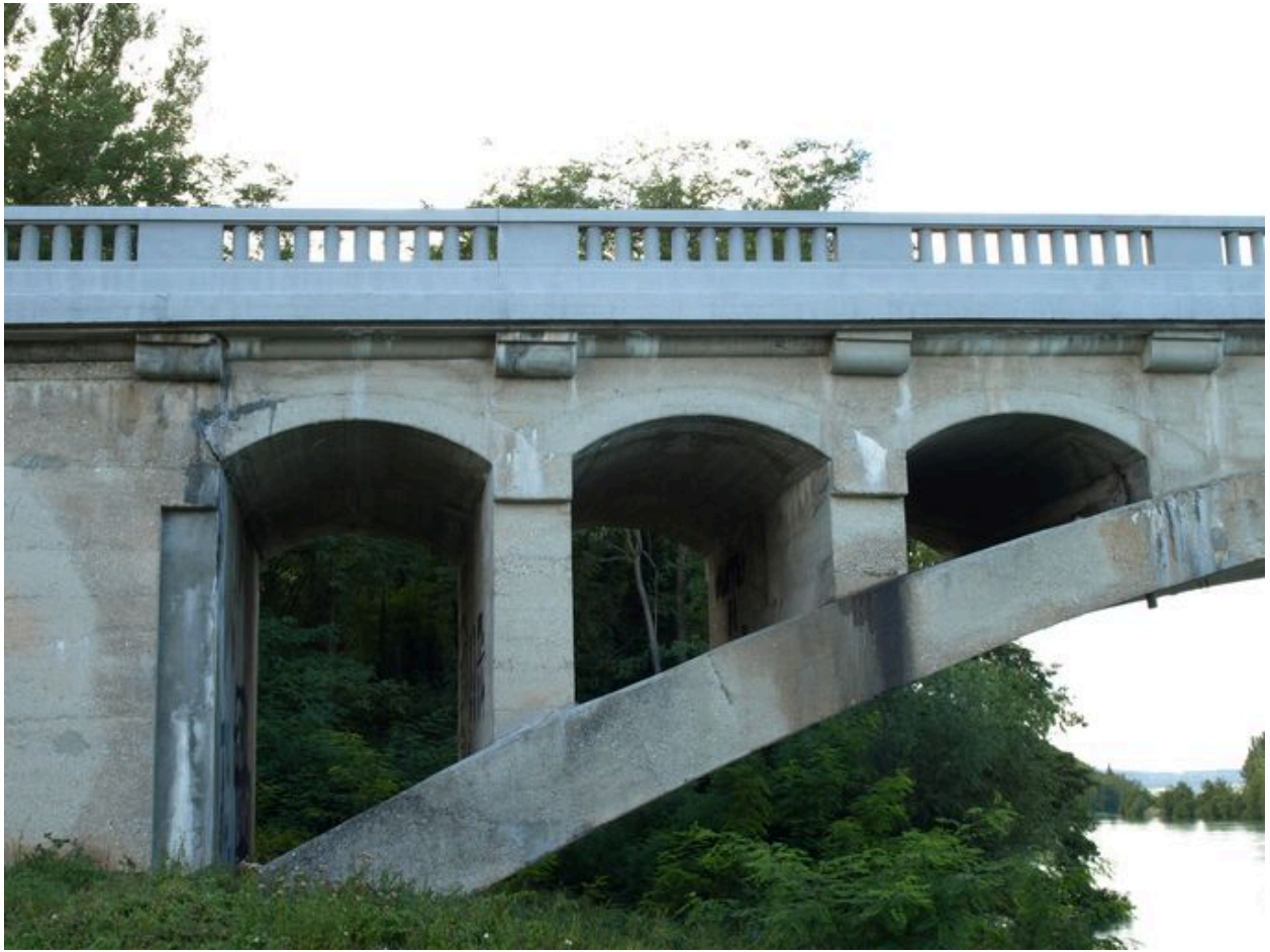
Tablier, élégissement (depuis la rive gauche)
