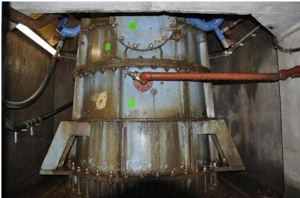
Détail d'une partie de la turbine d'un groupe vertical
