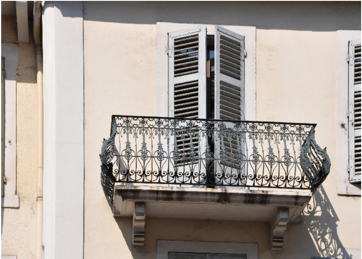
Détail d'un balcon du corps nord
