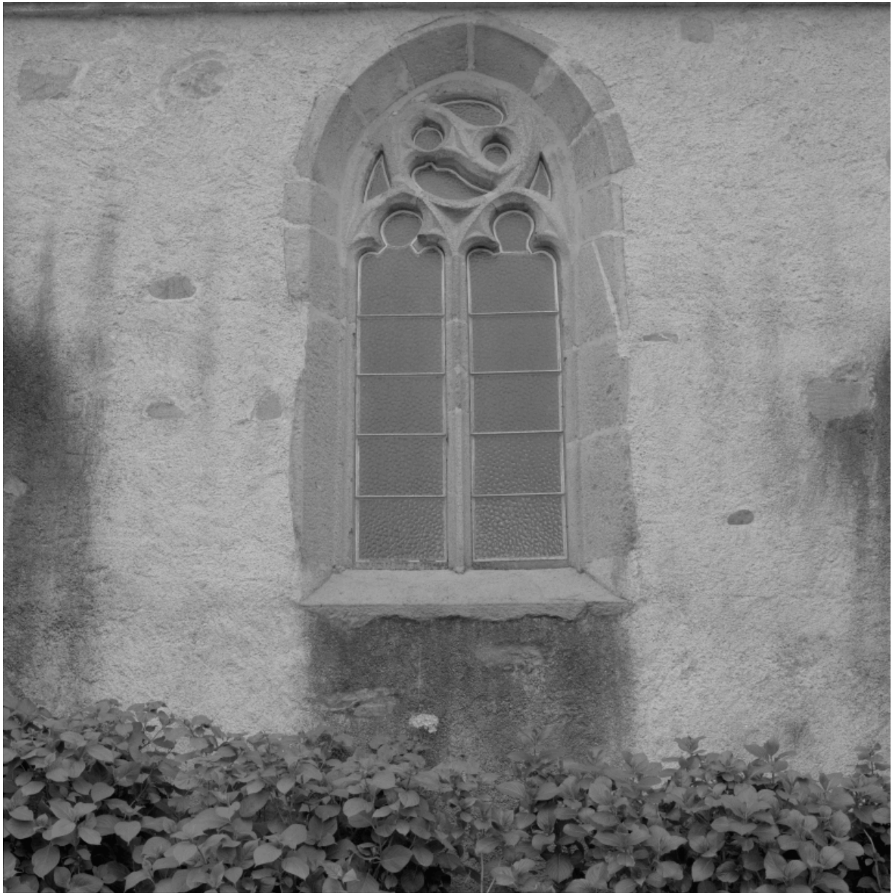
Remplage de la baie n°5.
