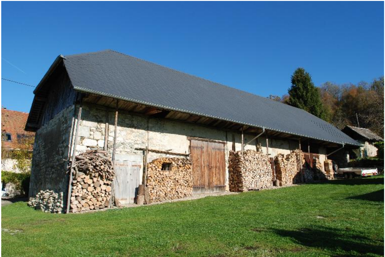
Vue d'ensemble de la grange-étable.
