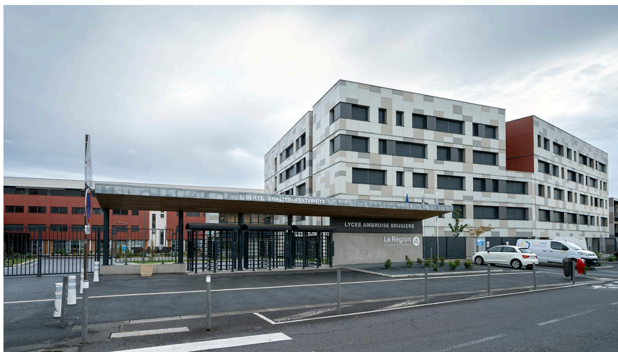
Vue d'ensemble depuis le nord-ouest (rue des Planchettes)
