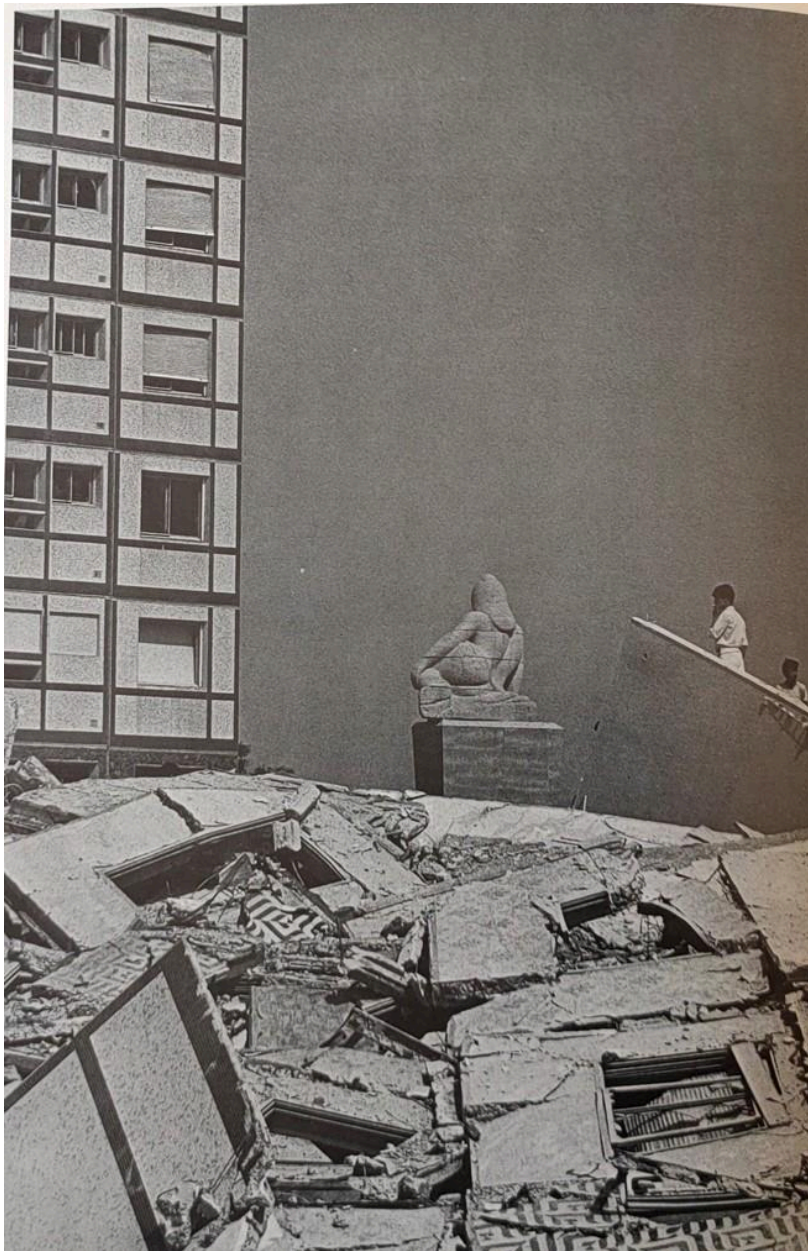
Détail démolition des barres (photo Rajak Ohanian)
