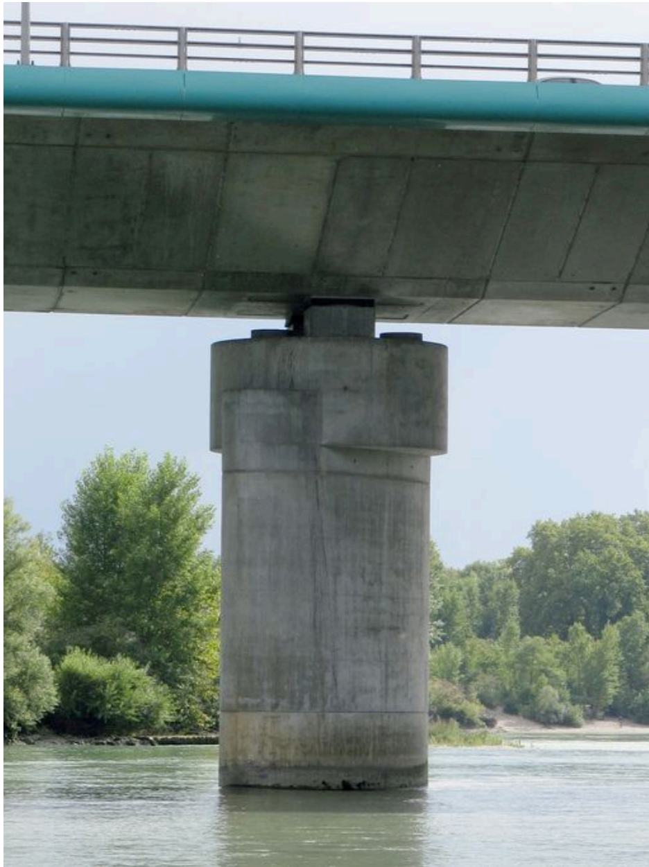
Pile, face amont, vue générale (depuis la rive droite)
