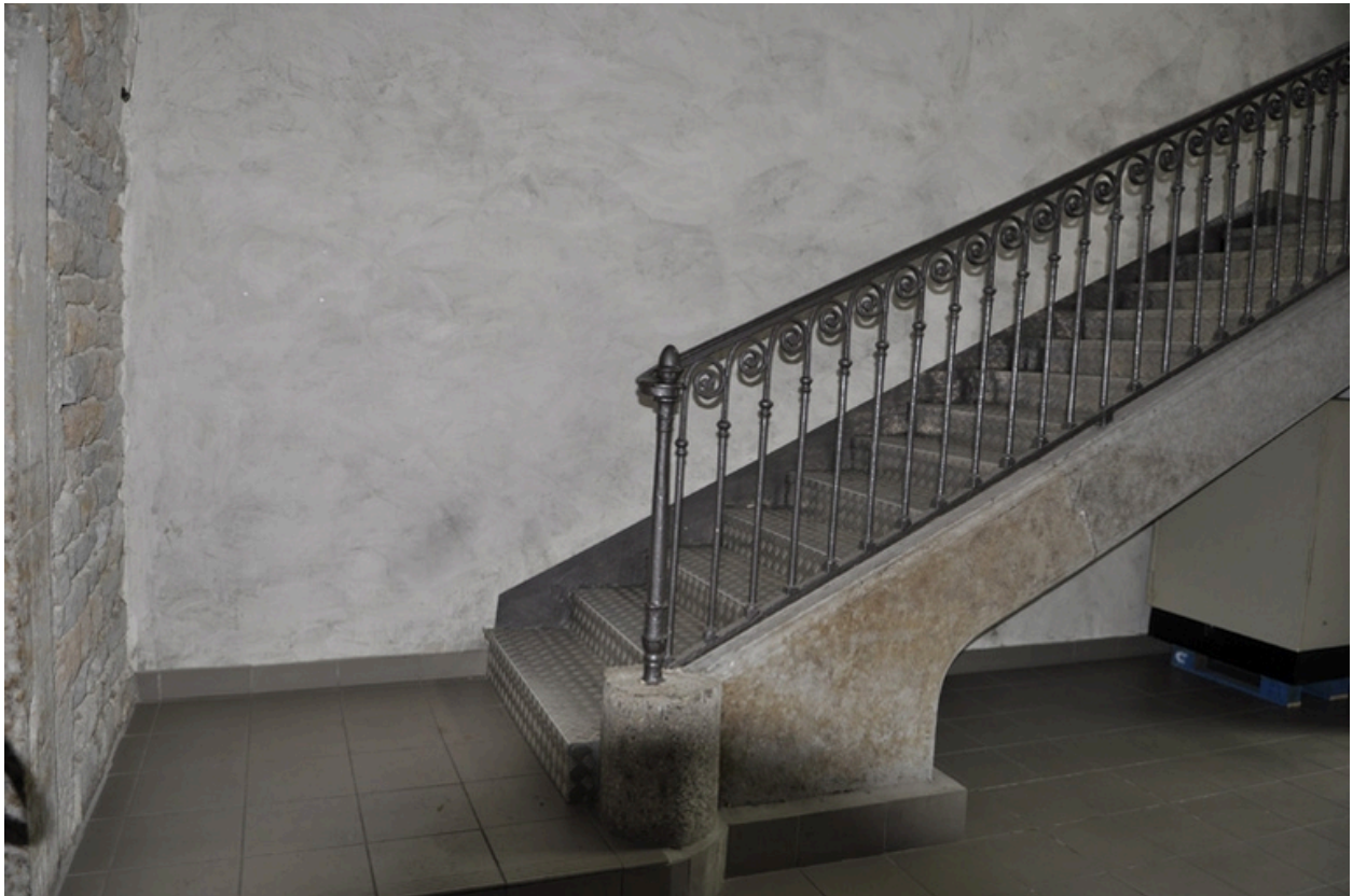
Vue de l'escalier latéral est.
