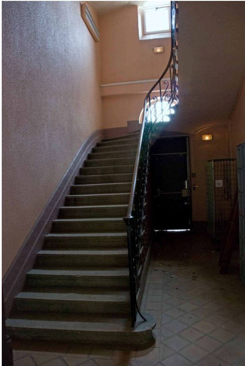
Escalier sud, première volée
