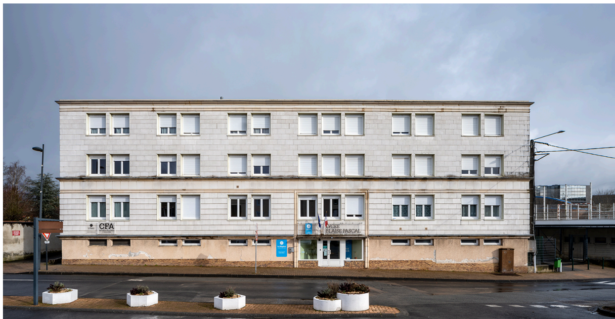
Vue de l'élévation principale et de l'entrée du lycée
