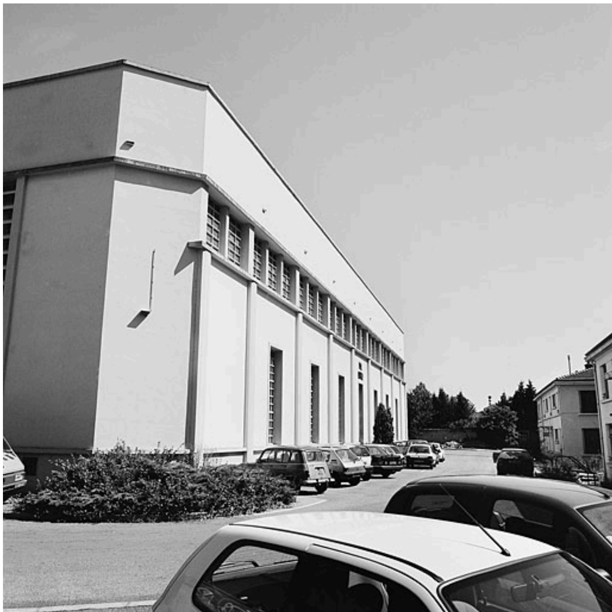
Hall mécanique : vue de la façade est
