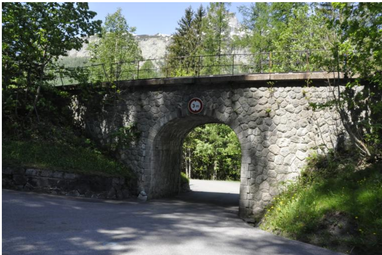
Vue de la face ouest du pont ferroviaire de Mont-Roc et de son arche principale
