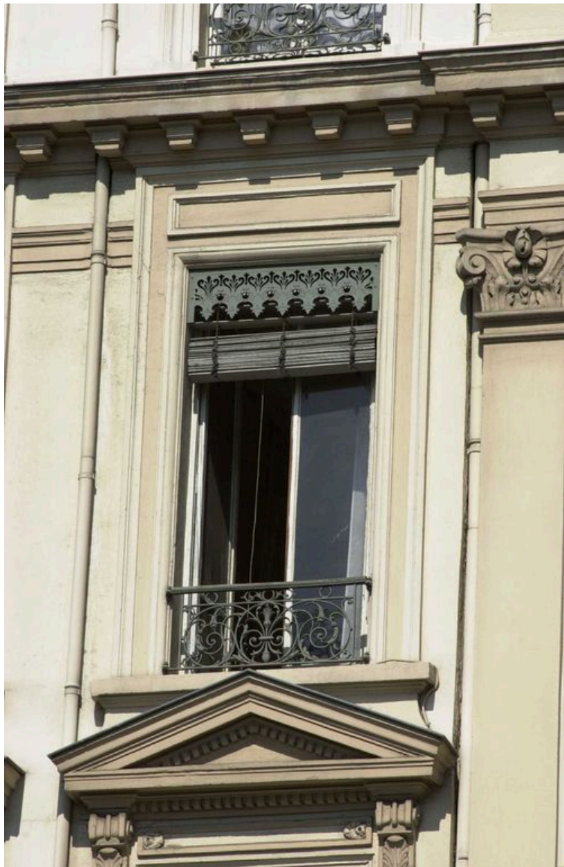
Fenêtre du 2e étage, grande rue de la Guillotière
