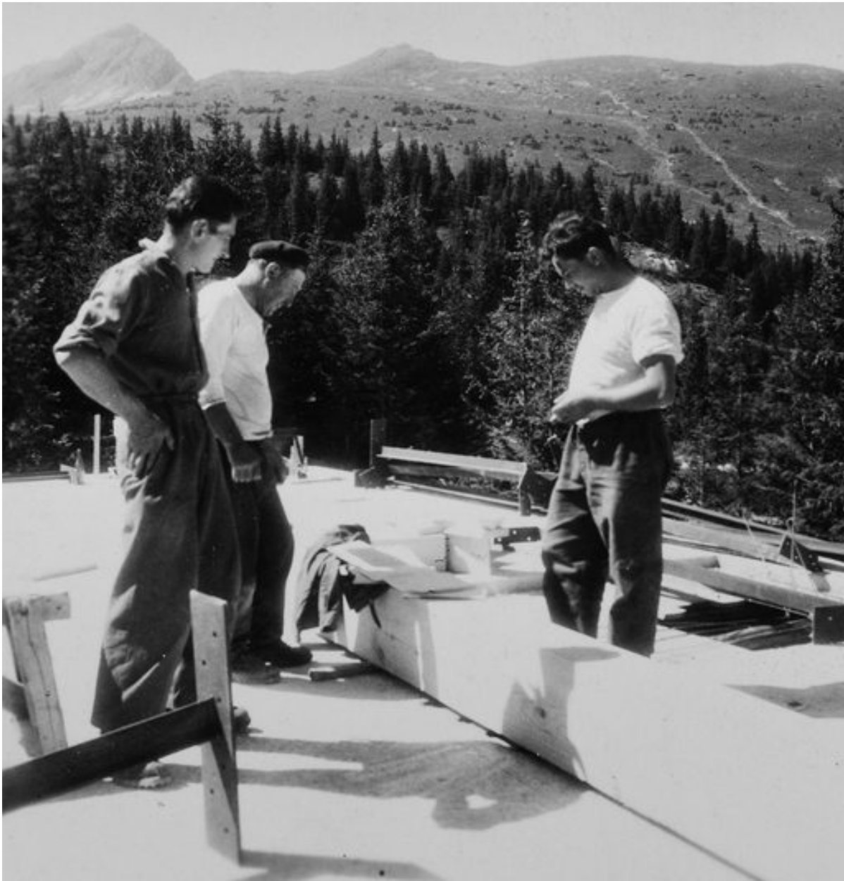
Denys Pradelle (à gauche) sur le chantier de construction. Photogr., [1950] (AD Savoie. 6J 100)
