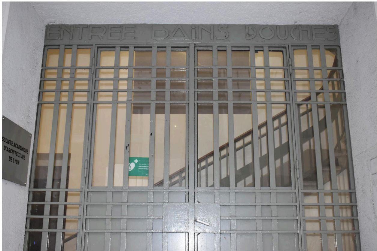
Détail ferronnerie et enseigne : "Entrée Bains Douches"
