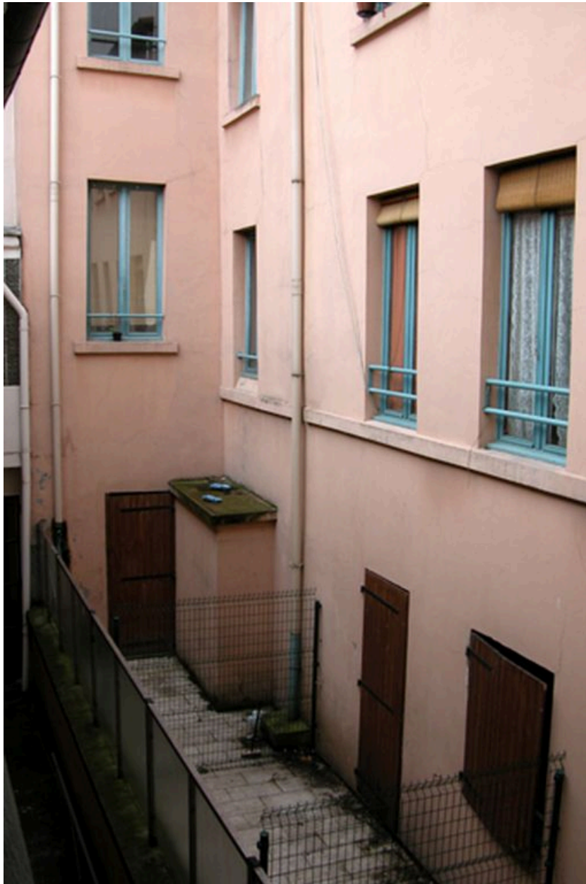
Vue de la cour et de l'élévation postérieure des corps de bâtiment depuis AD 15
