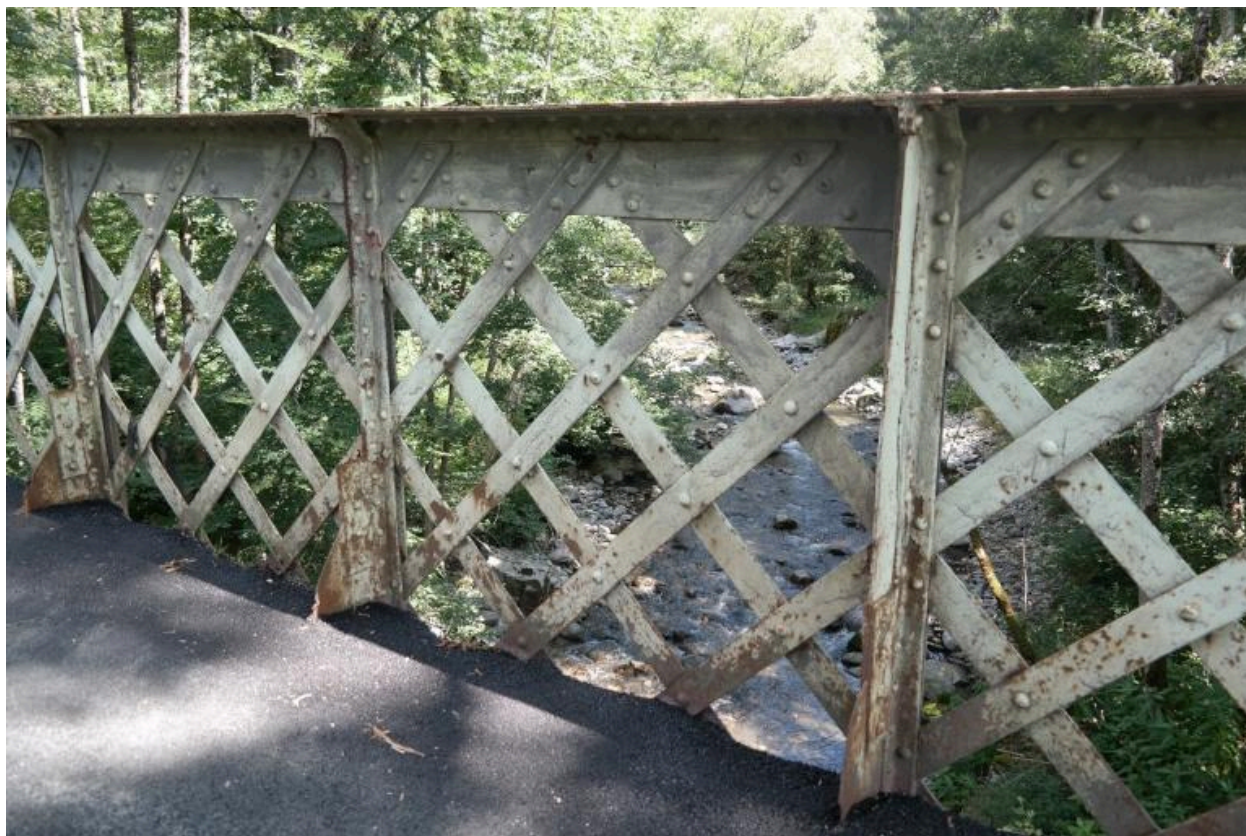
Passerelle de Sous-le-Pas, détail rambarde métallique
