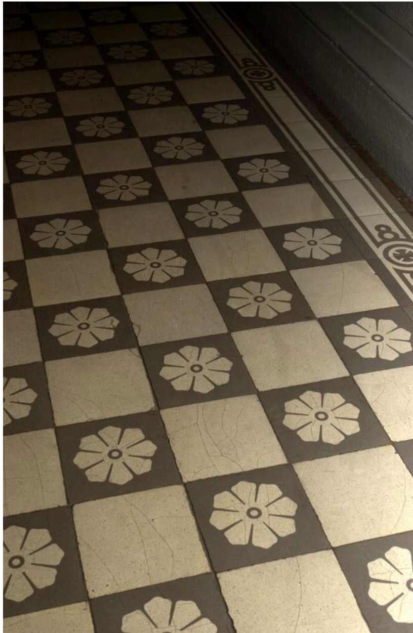
Carrelage en ciment moulé du vestibule
