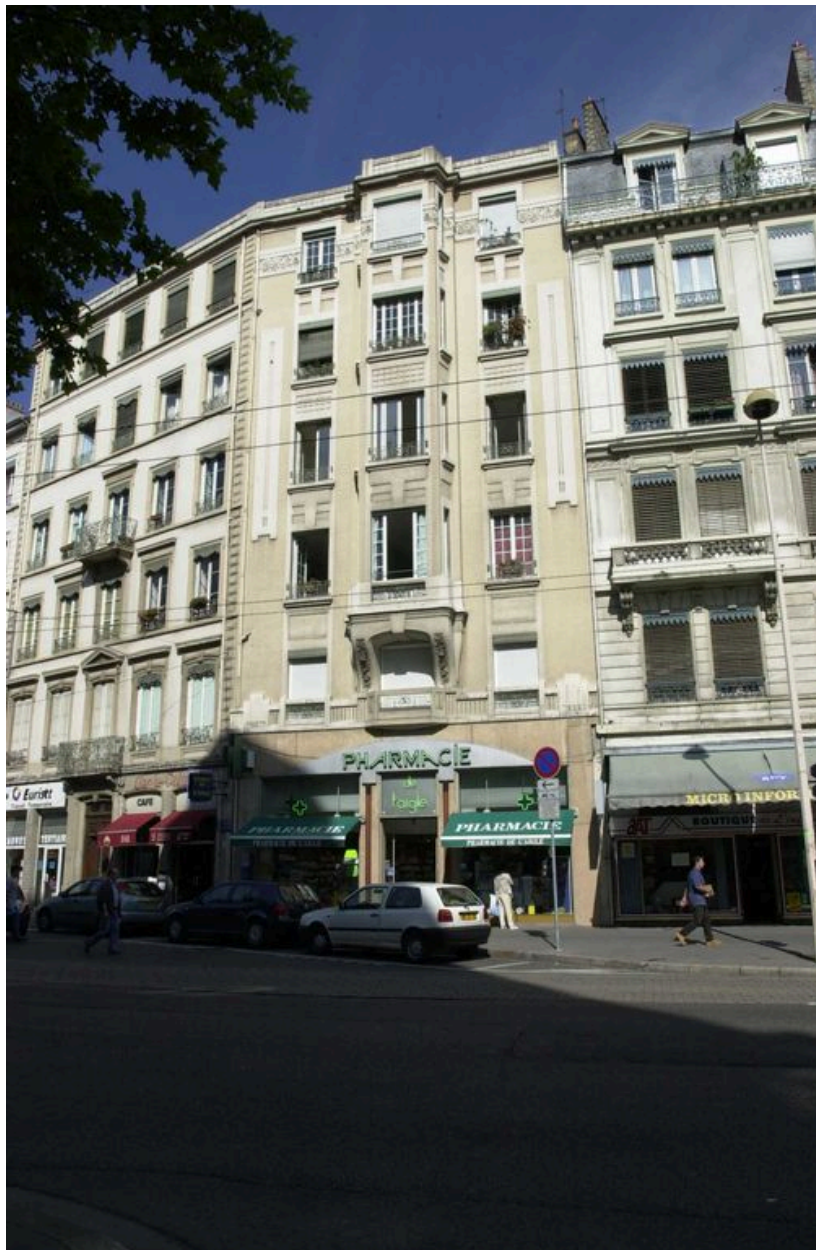
Vue générale de l'élévation
