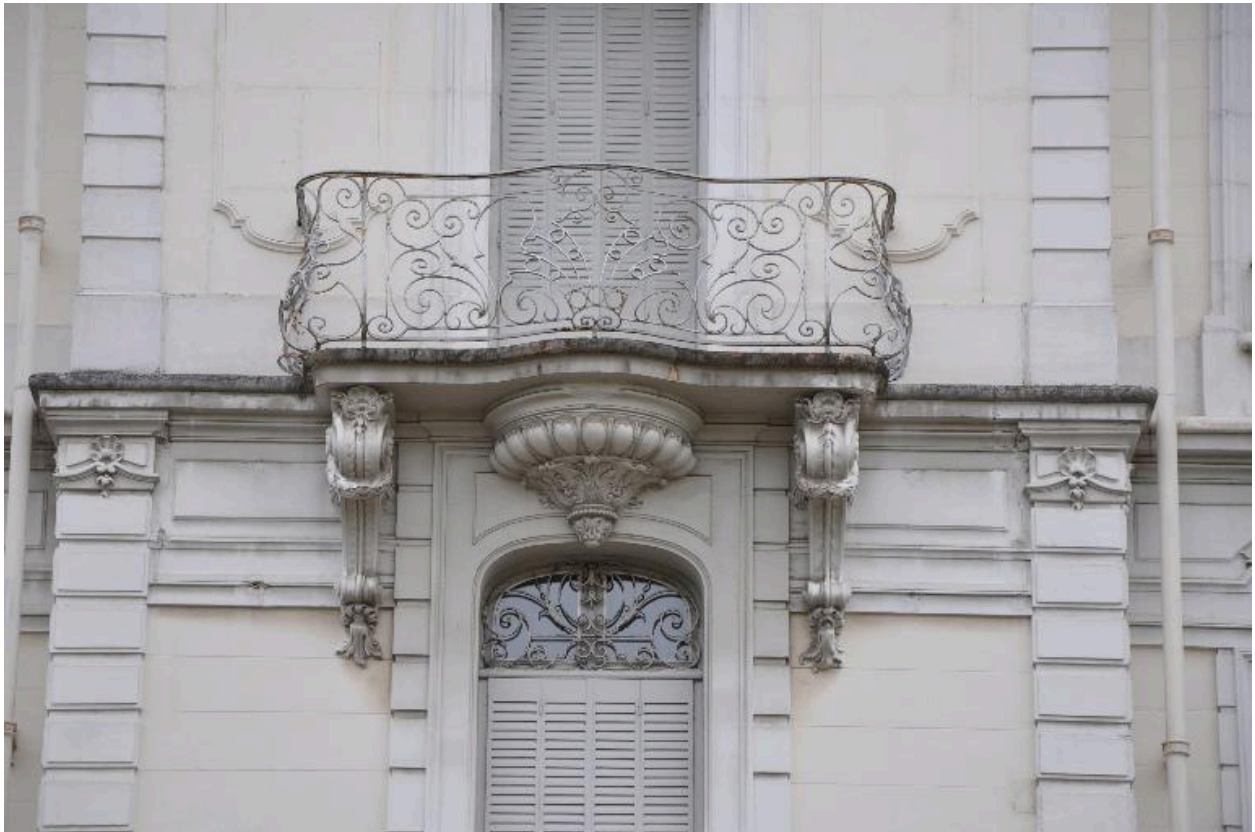
Détail du balcon sur culot
