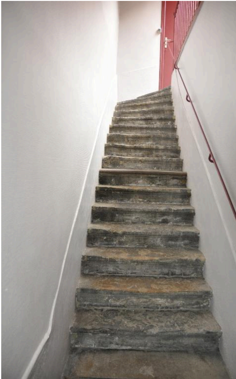
Vue de la première volée de l'escalier
