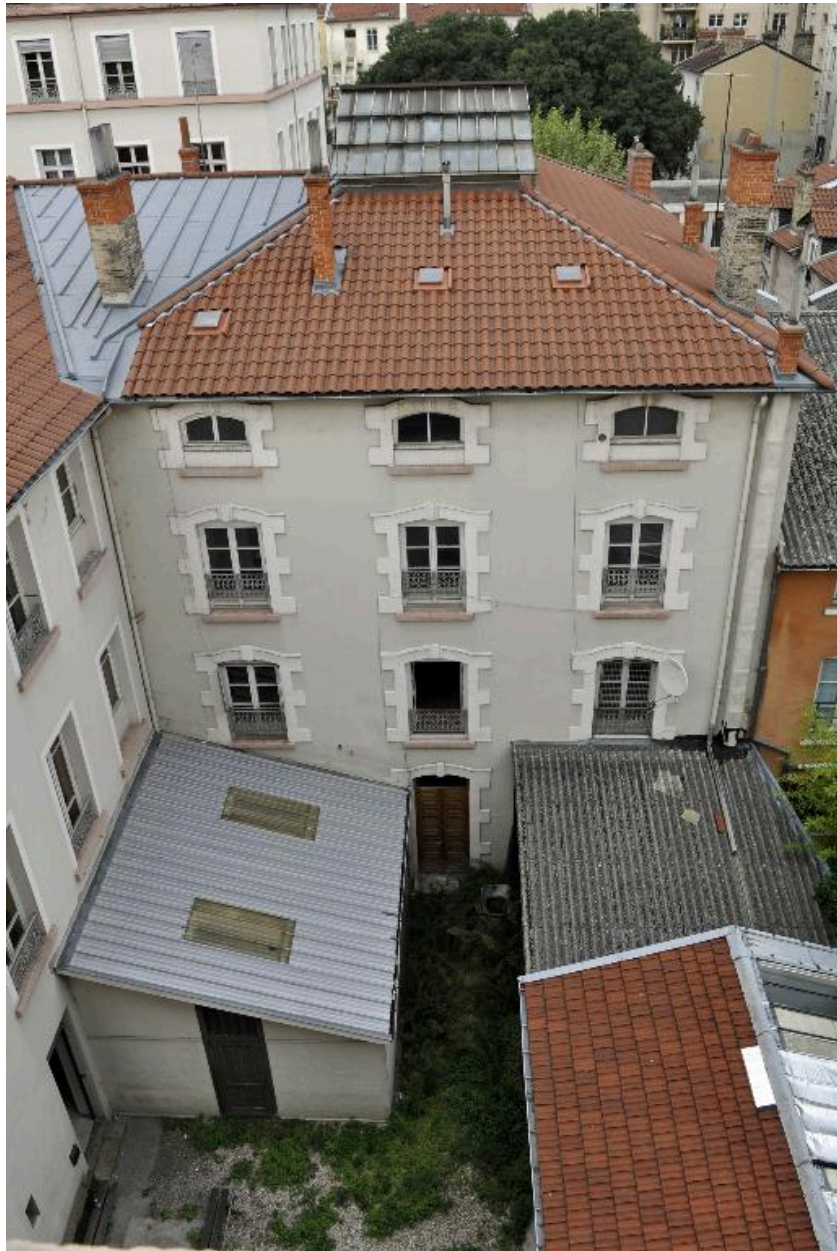
Bâtiment sur cour, élévation postérieure
