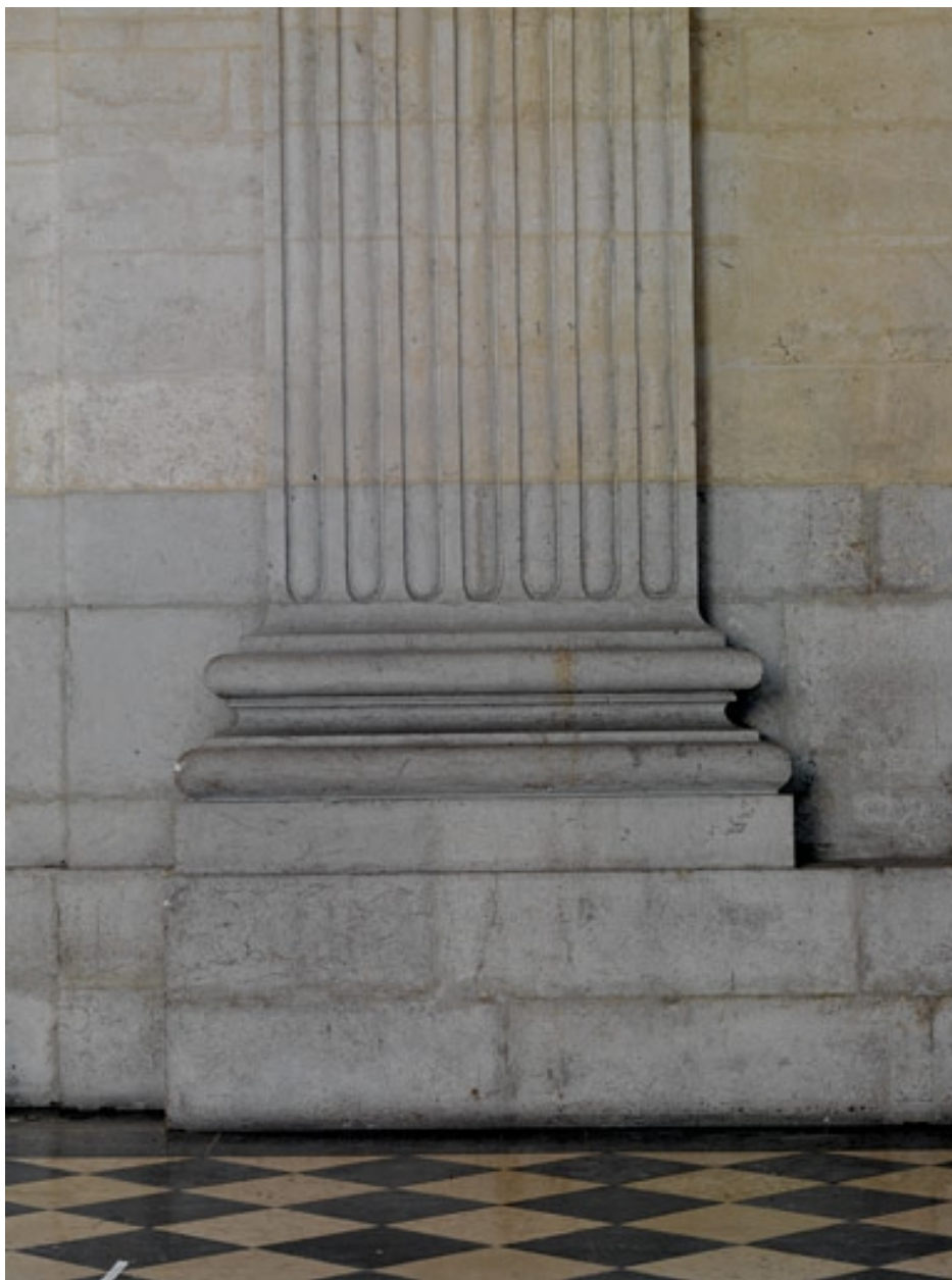
Base d'un pilastre
