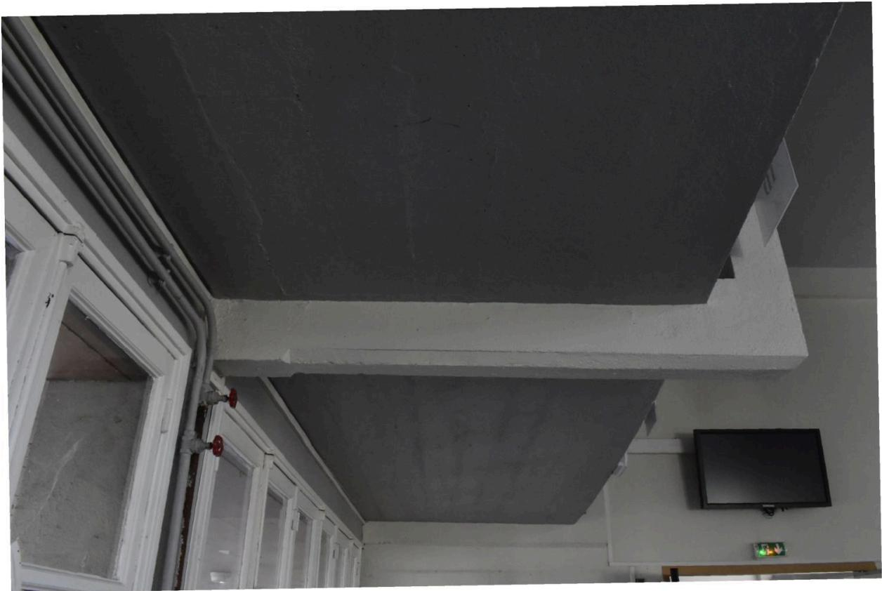
Détail du surplomb sur le préau de la salle dite "foyer-expositions" sur les plans, assuré par une "suspente en ciment armé". On peut noter le détail du chanfrein à congé, rare pour une pièce en béton de cette époque.
