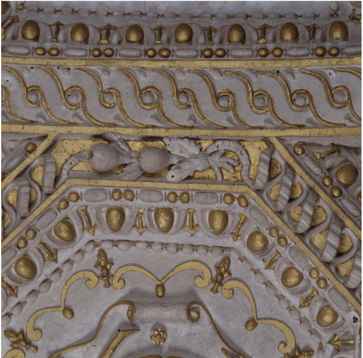
Voûtain de l'entrée, décor situé entre le caisson n°5 et la bordure.
