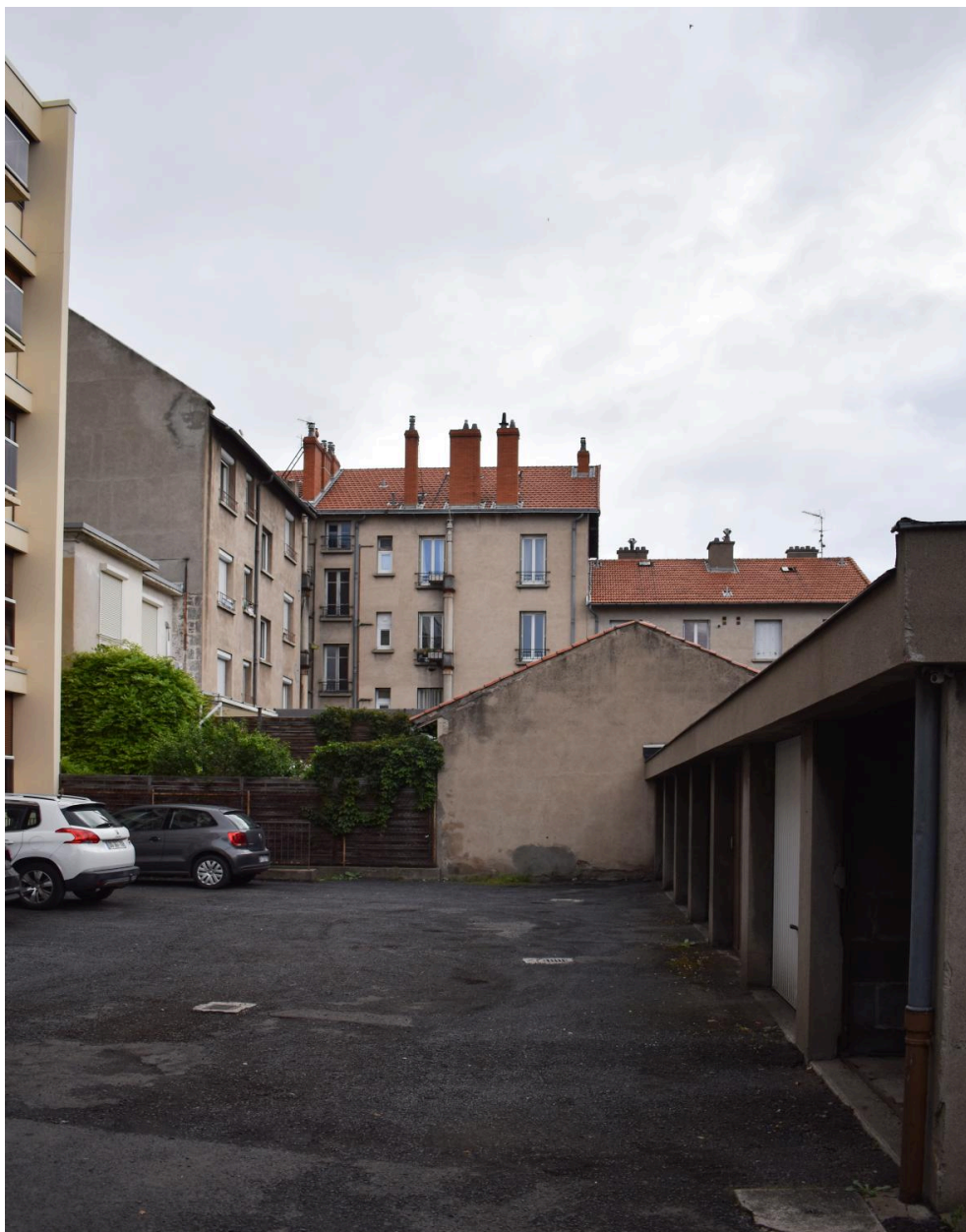
Vue des élévations postérieures depuis le coeur de l'îlot
