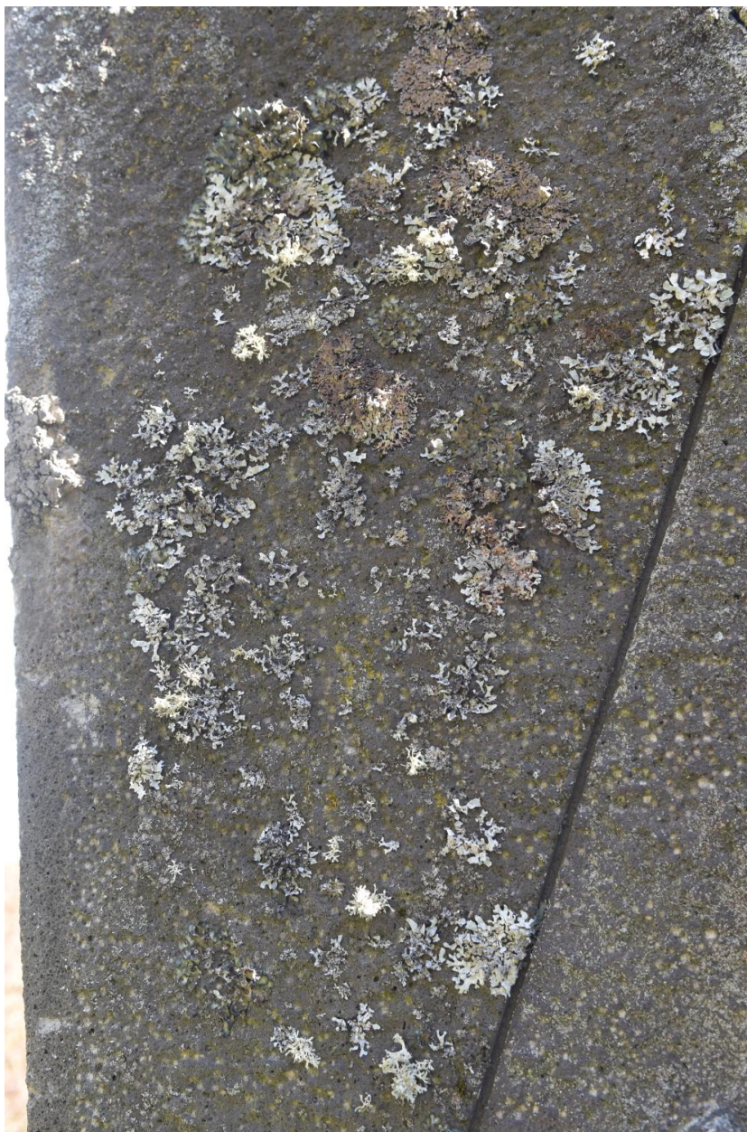
Détail des altération : mousses et lichens
