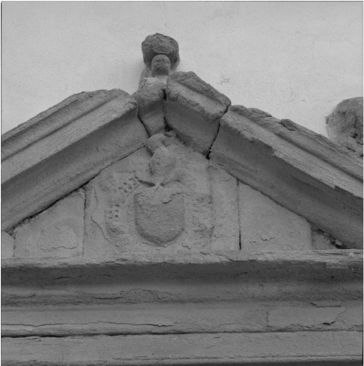
Bastion sud-ouest, porte du rez-de-chaussée ouvrant sur le jardin, fronton : détail des armoiries d'Urfé sculptées dans le collier de l'ordre de Saint-Michel.
