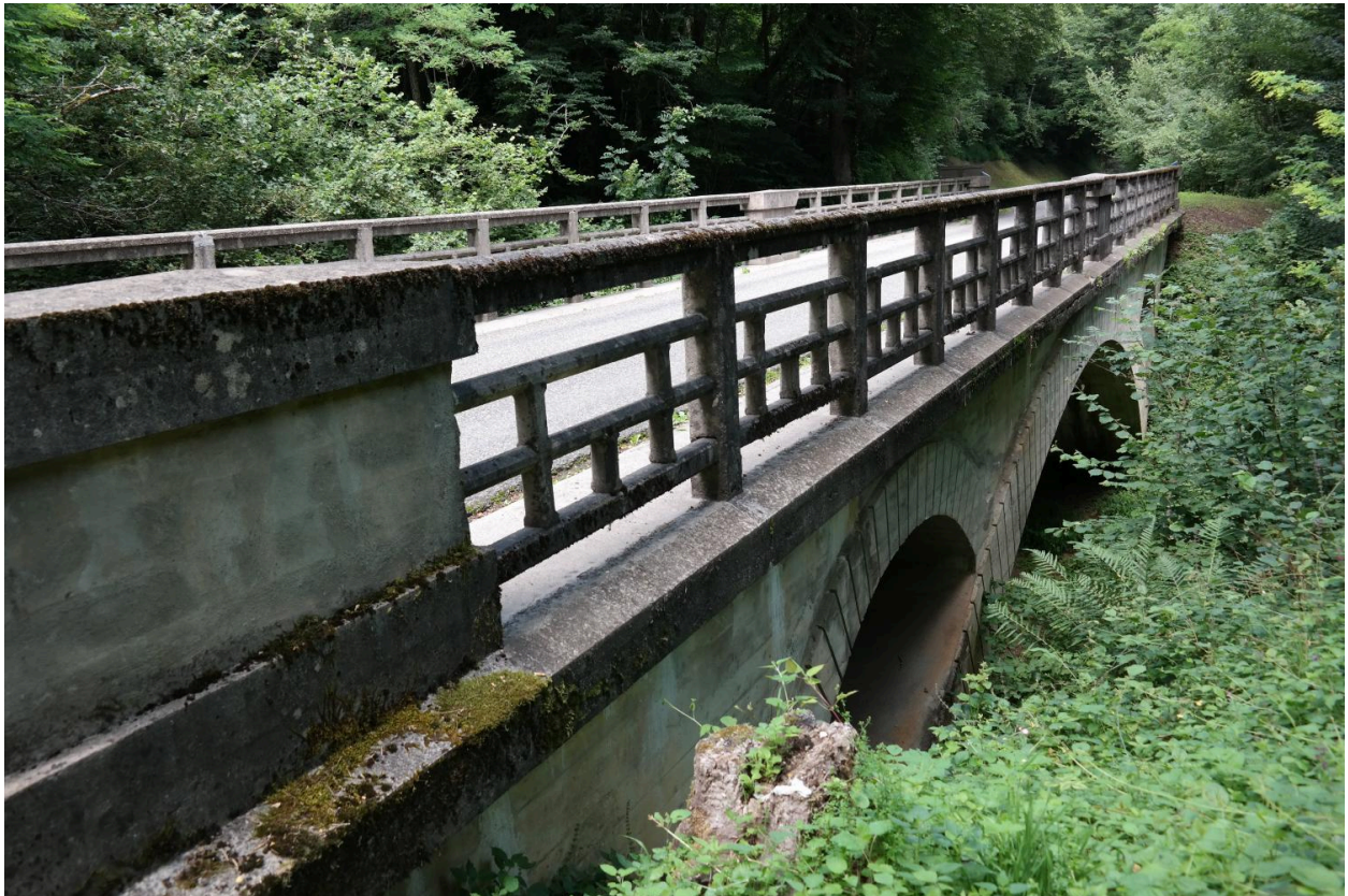
Pont du Parmand 1, vue de la face amont
