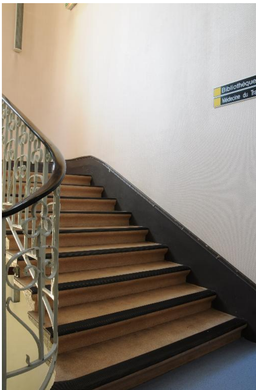
Escalier intérieur, palier et 1ère volée
