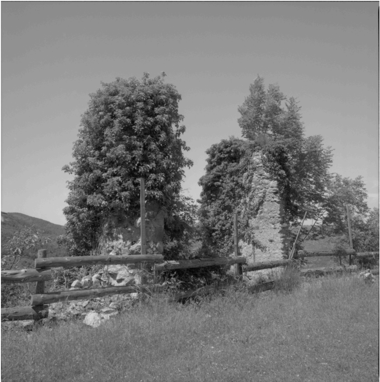
Première enceinte, premier baile, partie nord-ouest : détail d'une tour ronde ouverte à la gorge (tour n°12 du plan), du sud-ouest.
