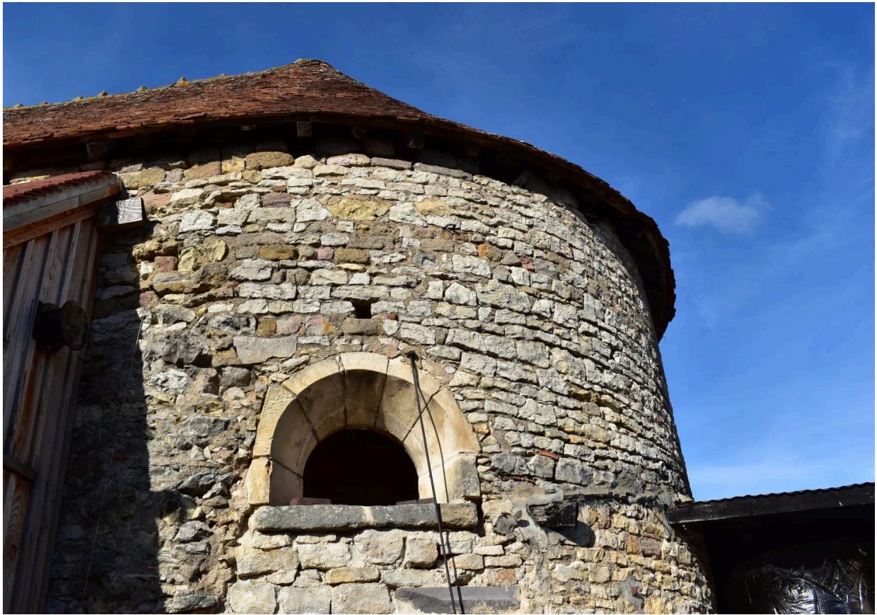
Détail du vestige d'une baie en plein cintre de l'abside, au sud-est.
