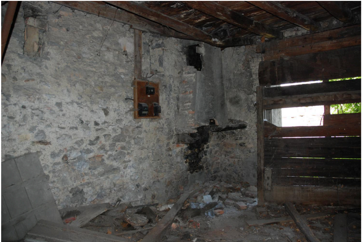
Vue intérieure, rez-de-chaussée : remise.
