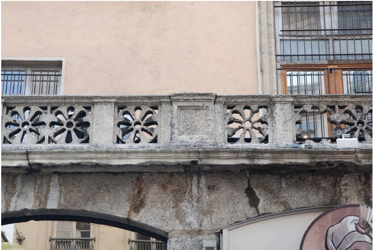
Elévation ouest : garde-corps
