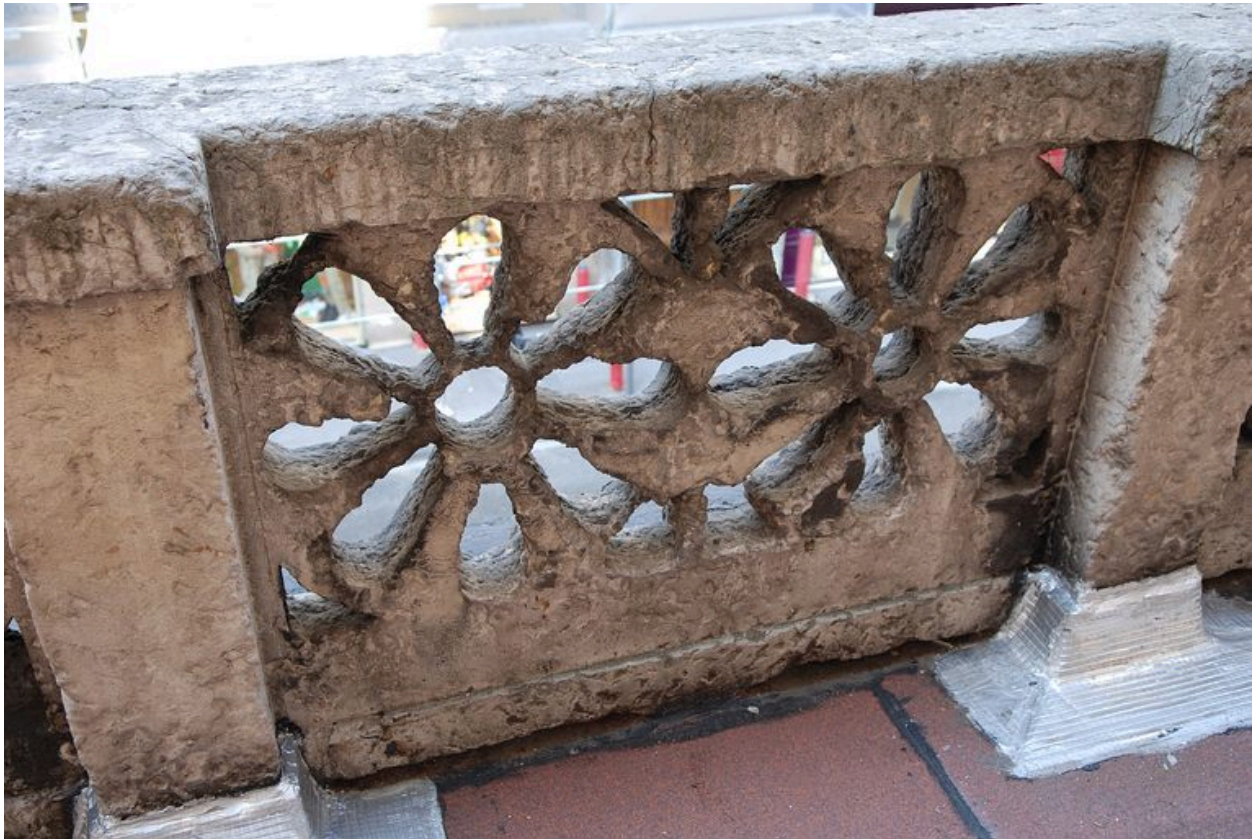
Elévation ouest : garde-corps de la terrasse, rosaces
