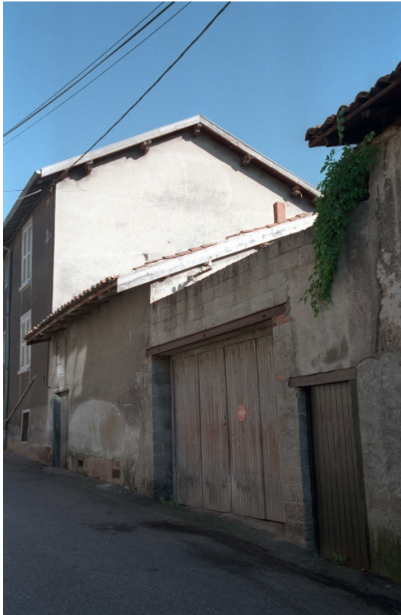
Boën, îlot 13, Ph. Raymond (rue) 24. Vue générale de la façade sur rue.
