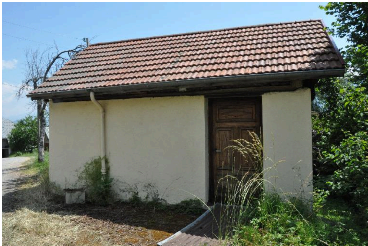
Façade nord du moulin aval.
