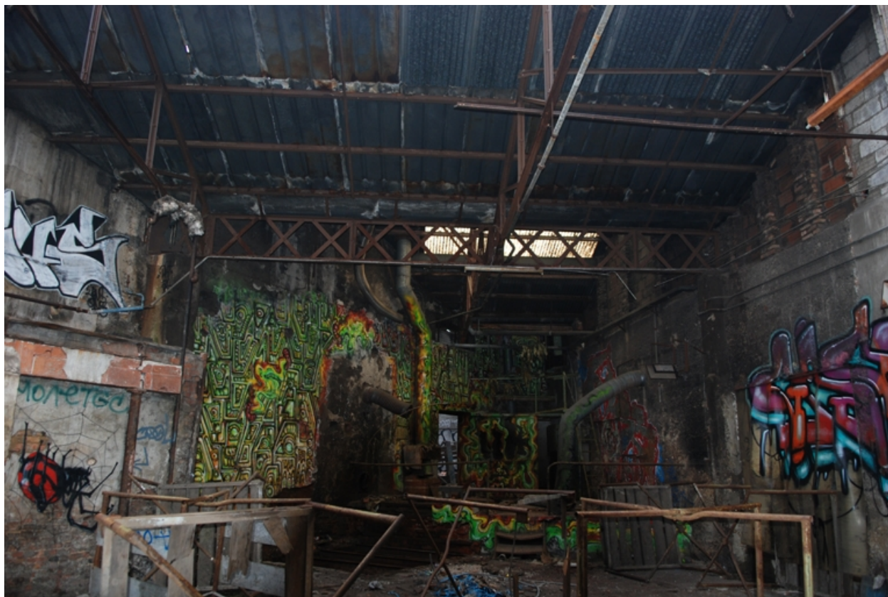
Vue d'ensemble avec détail sur la charpente et poutrelle à croisillons métalliques
